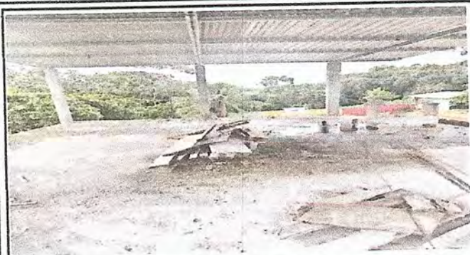
Foto 1: Se sustituye lámina perforada por lámina troquelada Aluzinc calibre 26 con elementos de fijación.
