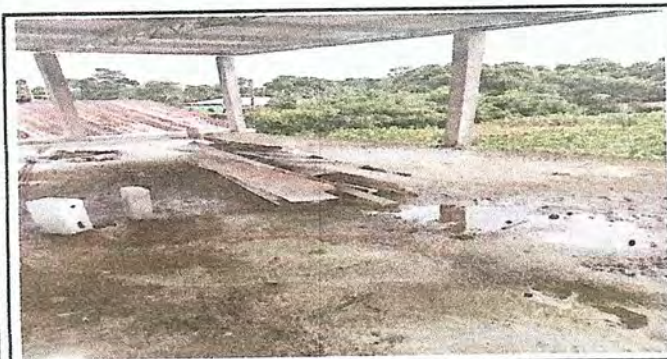
Foto 5: Muro Perimetral de block de 32 metros de longitud x 1.60 en aula de segundo nivel.
