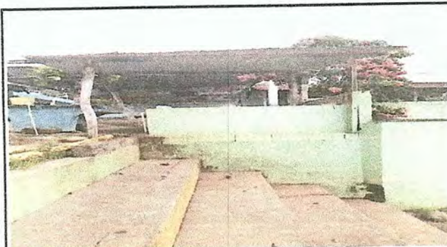
Foto 3: Reparación de muro perimetral con block y malla
