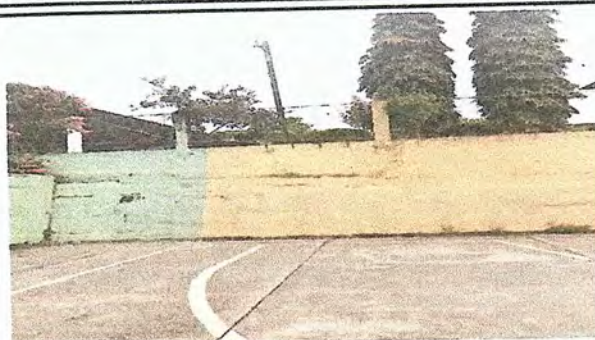
Foto 2: Reparación de muro perimetral con block y malla
