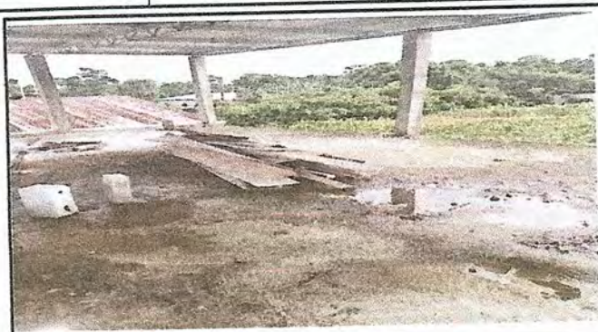
Foto 2: Sustitución de piso, por piso cerámico
