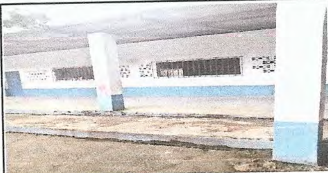
Foto 4: Pintura de puertas y balcones con pintura de aceite
